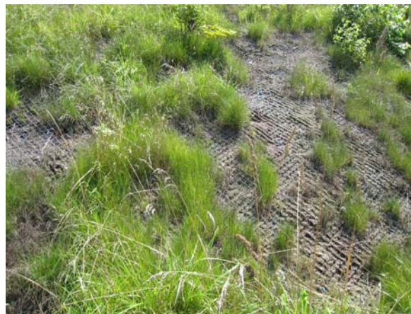
図—2 法面植生の枯死状況
