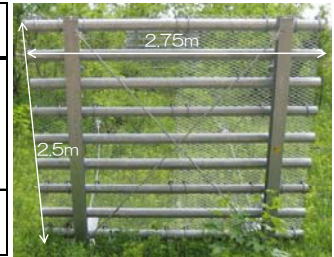
写真2 エクスパンドメタルを取り付けた雪崩予防柵
