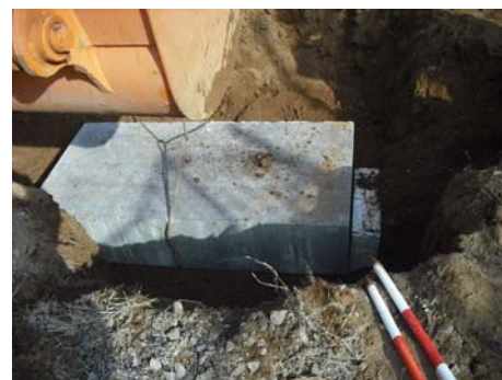
写真-5 障害物の埋込状況 (写真)
