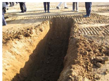
写真-3 自動掘削作業終了後の出来形
