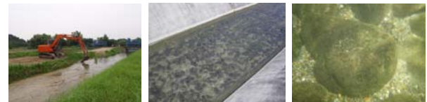
写真 5.1 砂投入の状況と砂の掃流状態
