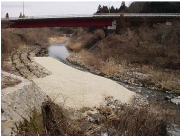
写真 3.1 土砂還元の状況：St. 5 の 100m 上流での土砂還元の様子。高水敷に設置されている。
