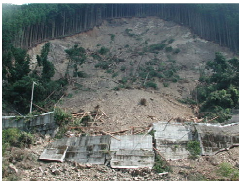
写真 2.3 ③岩盤崩壊性地すべりタイプ (宇井地区)
