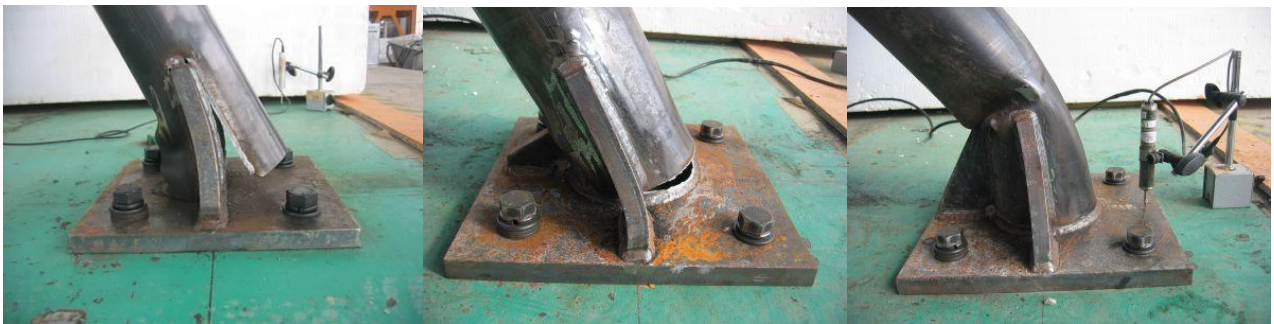
写真-II-1 実験後の変形状況(ガードレール支柱)
