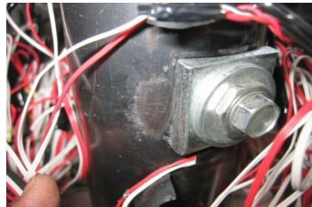
写真-III-4 ワンサイドボルト設置状況
