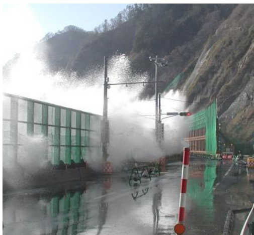
写真-I-1 越波状況の一例
