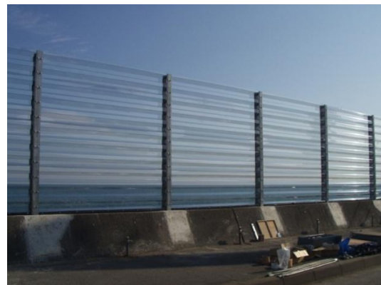
図-I-6 現場設置状況
