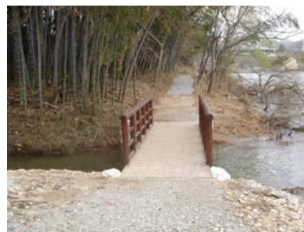
写真-3 水路に整備された木橋 1)
