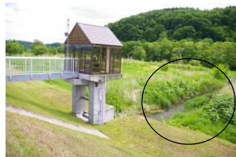
写真-8 川と水路をつなぐ樋門用水路（堤外） 少しの配慮でフットパスとして活用できる
