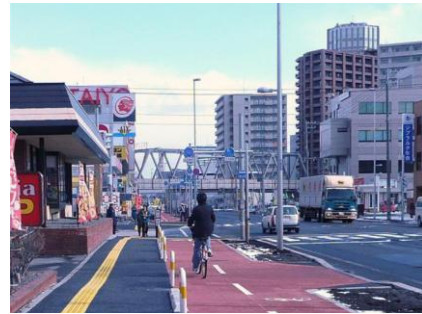
写真-12 柵により自転車走行帯を分離
