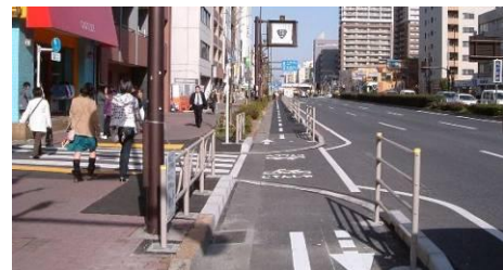
写真-8 車道部で柵と縁石により分離 20)
