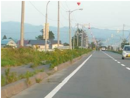
写真-4 歩道（郊外部）における雑草の繁茂
