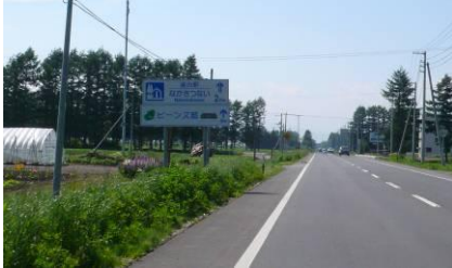
写真-3 自転車通行が可能な路肩拡幅の事例 (R236号中札内村)
