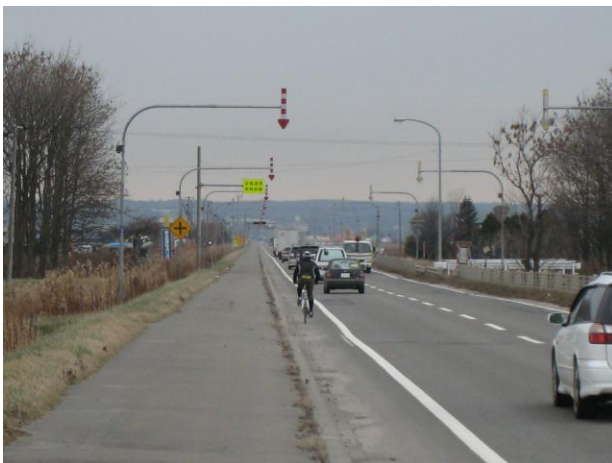
写真-2 現地状況
