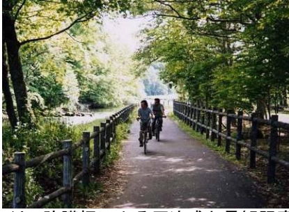
写真-14 防護柵による圧迫感と景観阻害 22)
