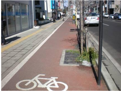
写真-9 植樹柵による幅員減少で快適性が低下
