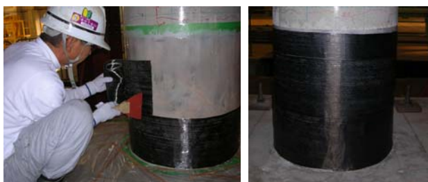
(b) 修復作業の様子と復旧後の柱基部 図-3 速乾性材料を用いたCFS巻立て工法
