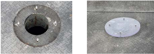
写真-9 カメラ挿入用点検穴
