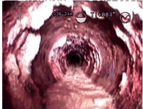
写真-7 大口径集排水ボーリング集水管内の状況
