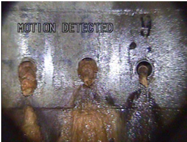
写真-10 集水管孔口の状況
