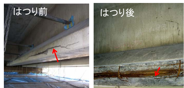
図-6 ひび割れ状況とはつり後の破断状況
