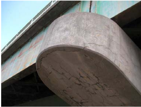
図-10 調査した橋梁はり部
