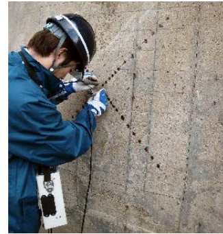
図-13 弾性波伝播速度測定状況（現場での測定）
