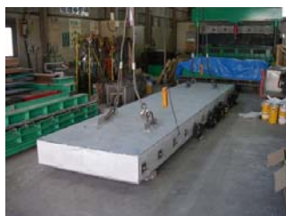
写真 I-5 合成頂版供試体の完成状況
