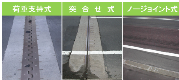
写真Ⅲ-1：伸縮装置の種類
