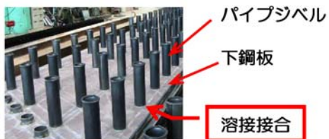
写真 I-2 合成頂版の内部鋼板組立状況
