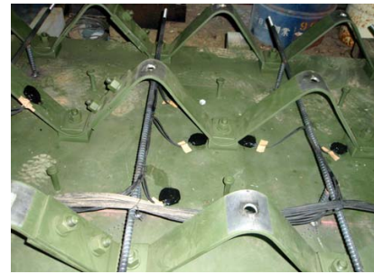
写真 I-9 下鋼板とトラス部材の組み立て状況
