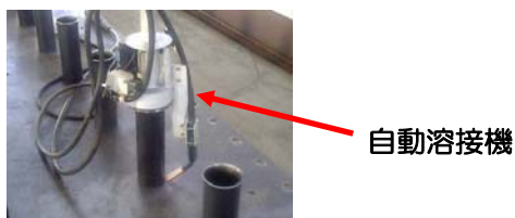
写真 I-3 パイプジベル溶接施工状況
