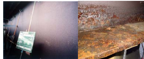
写真-5 補修前の状況
