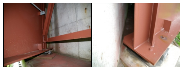
写真-6 補修後の状況(6年経過後)
