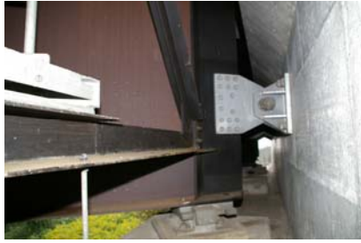
写真-3 漏水等が生じていない箇所の塗膜の状況
