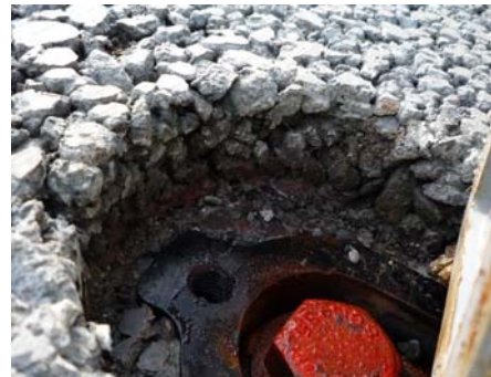
写真-4 ポーラスコンクリート舗装版内部状
