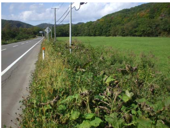
写真-1 施工後7年経過したすき取り物の施工箇所
