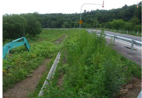
写真-2 すき取り物の施工厚さを薄くした施工箇所
