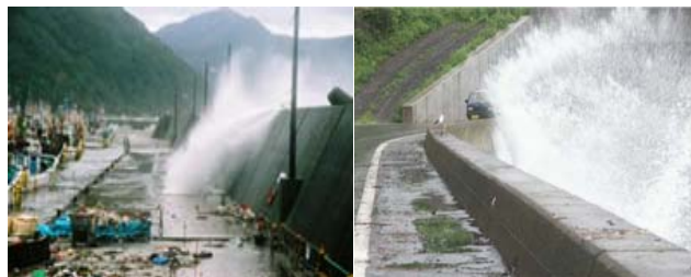
写真-12 護岸からの越波状況
