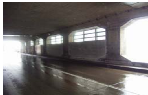
(b) 覆道内の状況
