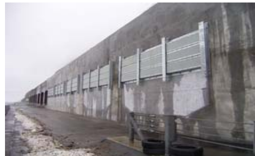
(a) 海側からみた状況
