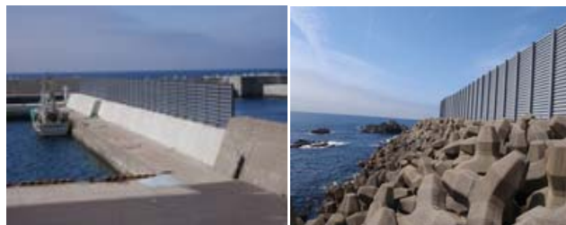
写真-13 防波フェンスの設置例
