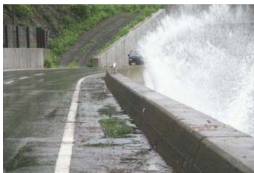
写真-1 海岸道路への越波状況
