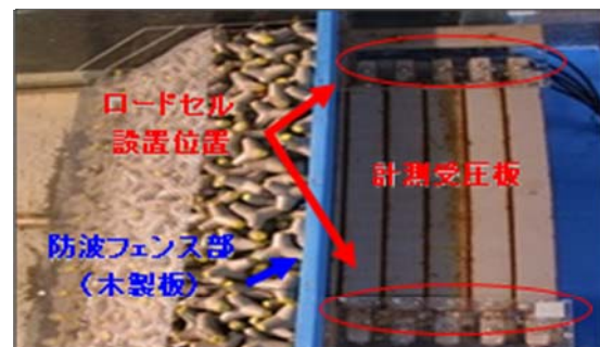
写真-19 受圧板の設置状況
