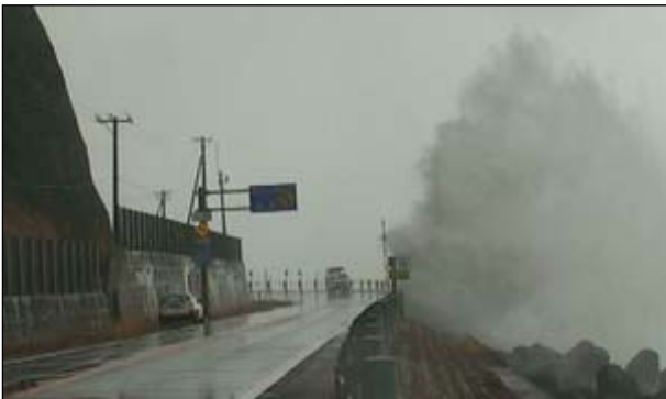
写真-18 A 海岸の越波状況
