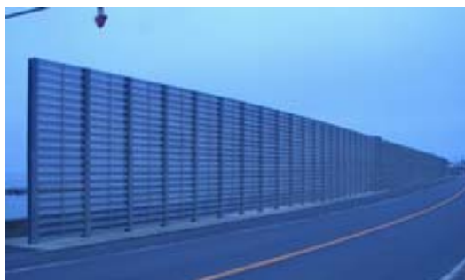
写真-2 越波対策工の例（防波フェンス）
