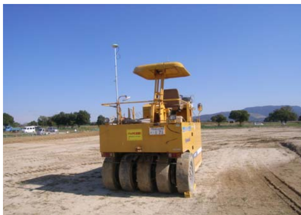
写真-9 タイヤローラによる施工
