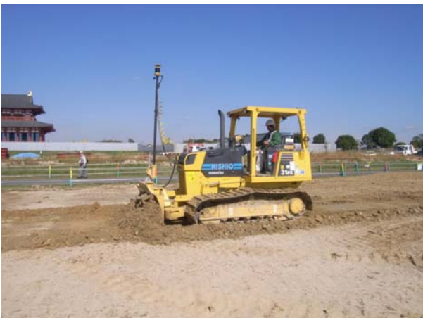
写真-5 3D-MCブルドーザーによる造成
