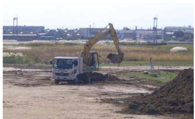
写真-7 3D-MGバックホウによる掘削
