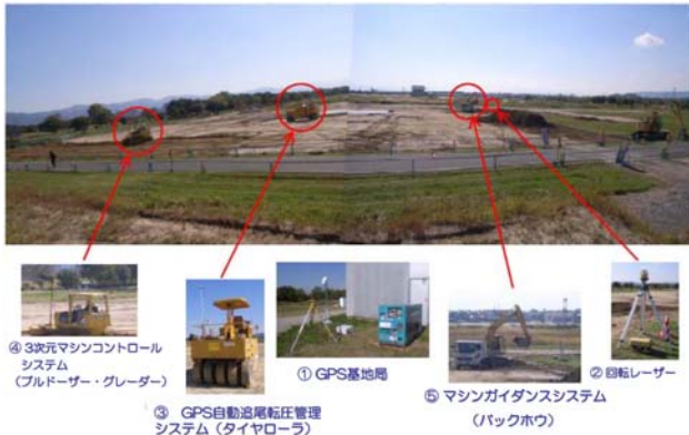
写真-4 情報化施工の全体構成
