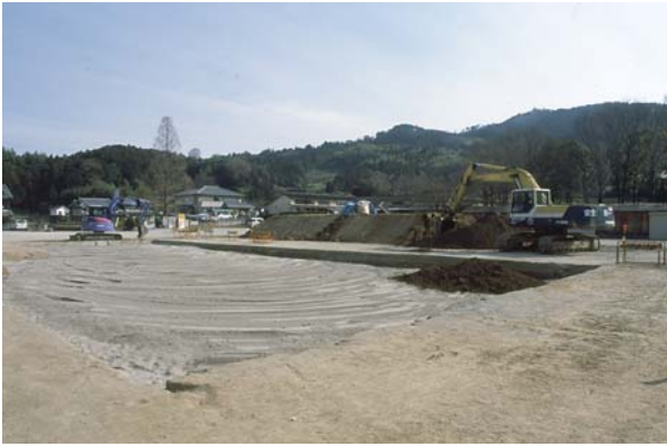
写真－1 保護砂の撒き出し状況
