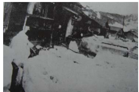
図-5.3 1952年十勝沖地震で発生した津波とともに遡上した流氷による家屋の被害状況の例(北海道浜中町)(根室測候所蔵、1952年十勝沖地震調査報告書 12 より)
