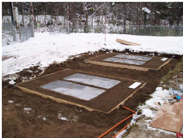
写真-1 積雪重量計設置状況 (定山溪ダム)
