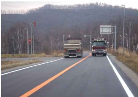
写真-1 北海道郊外部の典型的な2車線道路
