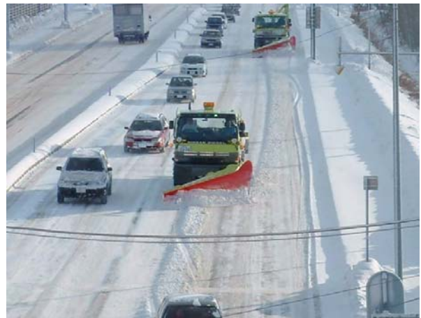
写真-3 除雪による車線上の雪堤発生状況
