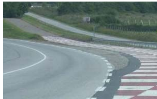
図-4 抵抗舗装帯（山間部の下り勾配部） （出典：RISER 4) ）
