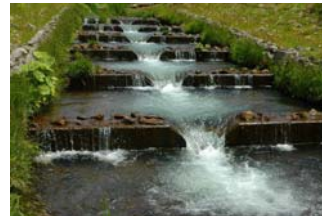
階段式落差工
