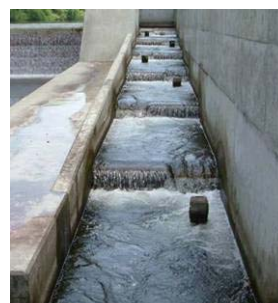
写真－4 切り欠き付き隔壁
