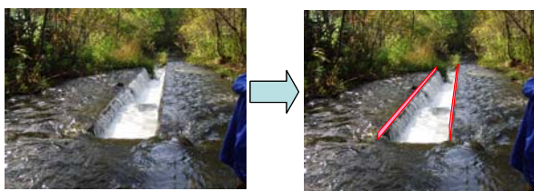
図-11 排水路落差工での改善策
