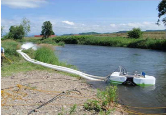
写真-13 進水状況
