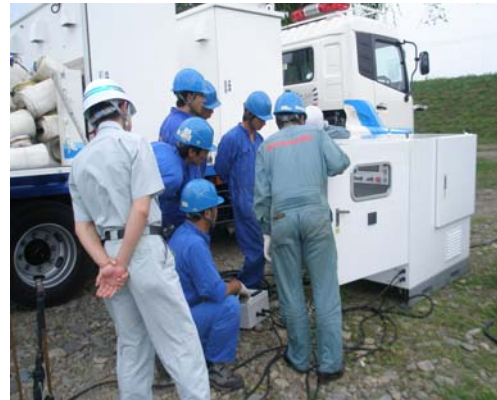
写真-15 操作盤接続作業状況
