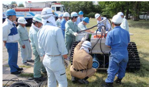
写真-16 排水ポンプ搭載作業状況
