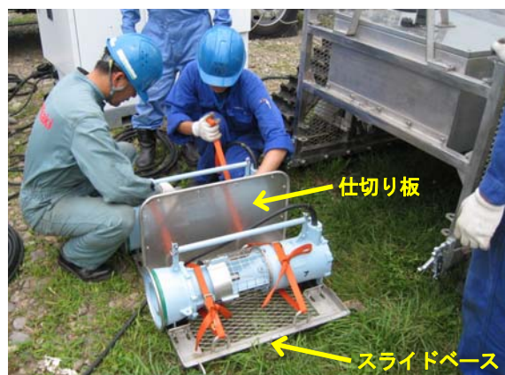
写真-8 排水ポンプ搭載状況
