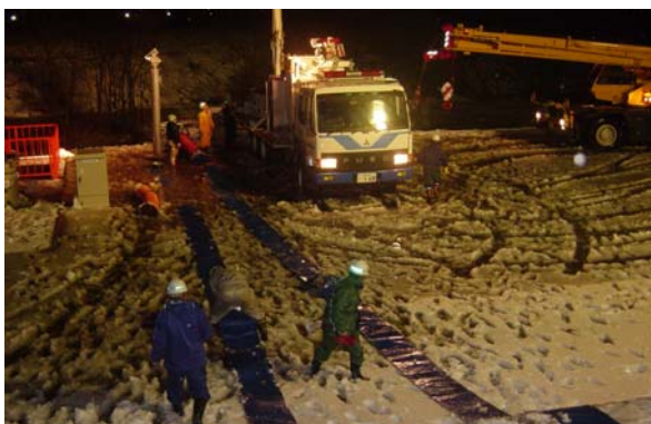
写真-1 平成19年1月十勝太での排水作業
