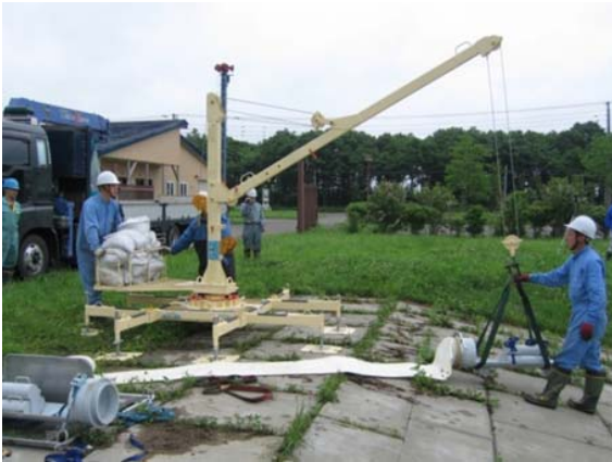
写真-20 可搬装置組立後
