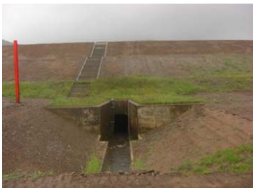
写真-17 自走装置で排水ポンプを投入できない現場の例（旭川開発建設部名寄河川事務所管内）
