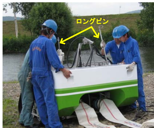
写真-7 フロート脱着作業状況
