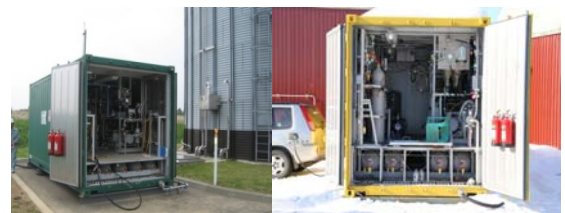
写真-4 バイオガス精製圧縮充填装置
