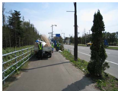
写真-9 運搬機械への積み込み
