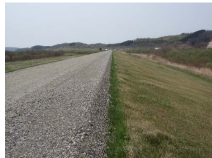
写真-5 施工完了
