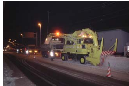
写真-1 ロータリ除雪車での積込（巻出1）
