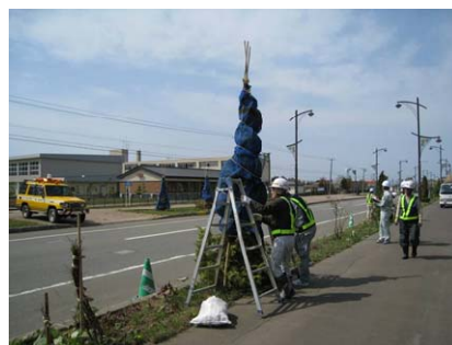
写真-10 脚立の使用による撤去作業
