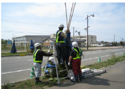
写真-7 竹による冬囲い撤去状況
