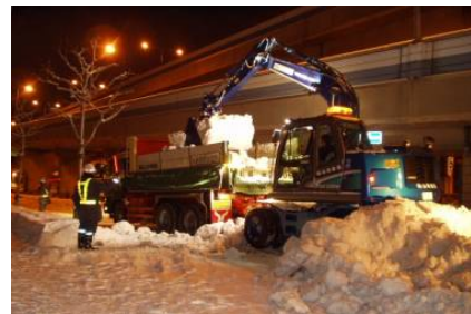
写真-2 バックホウでの積込（巻出2）
