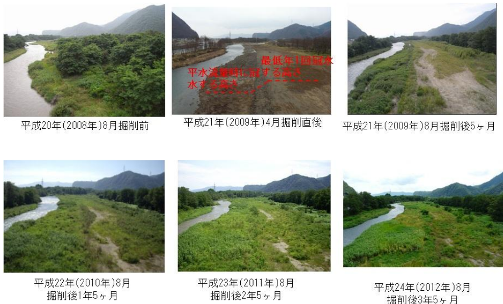
図-7 鼠地区における試験的河道掘削後の河岸域周辺の景観の遷移
