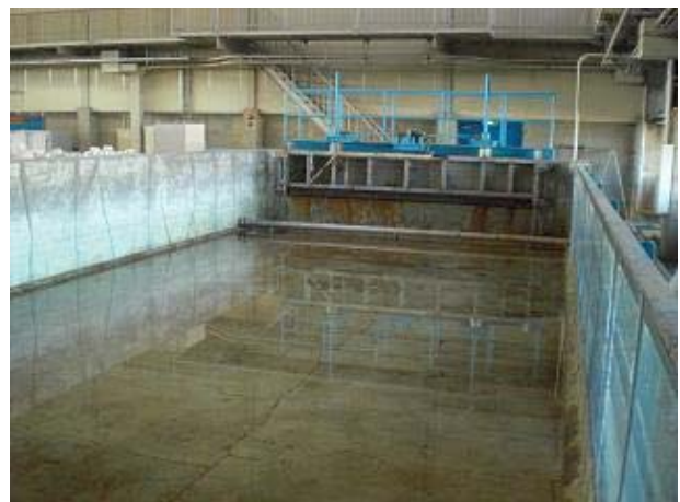
写真-7 凝集処理水槽（貯水前）
