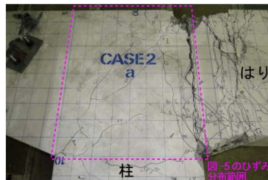
図-2.5 実験終了後の接合部付近のひび割れ状況
