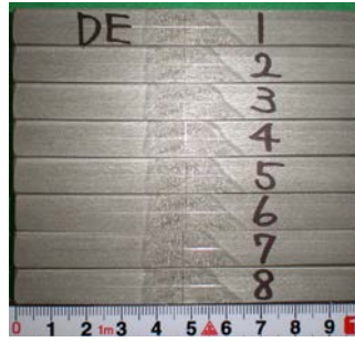
写真-3 溶接部の写真
