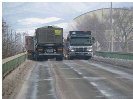
写真-1 路肩への堆雪による幅員狭小化の例
