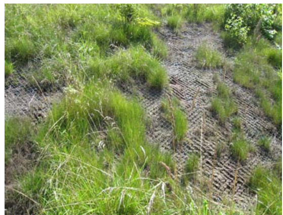
図-3.1 法面植生の枯死状況
