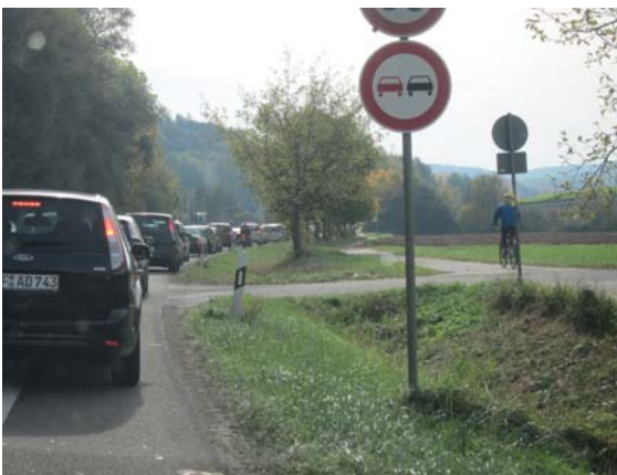
写真-5 副道を設置し軽車両(自転車、農耕車など)を分離(ドイツ)
