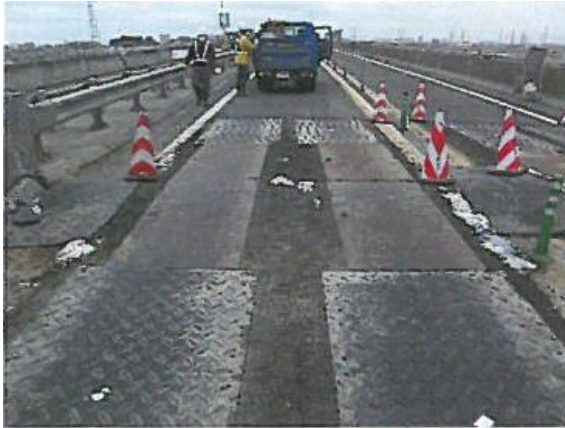
図-12 敷き鉄板による段差修正
