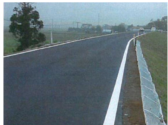
図-14 打ち換えが完了した道路
