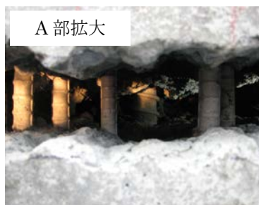
写真-7 開放溝の施工終了後の状況
