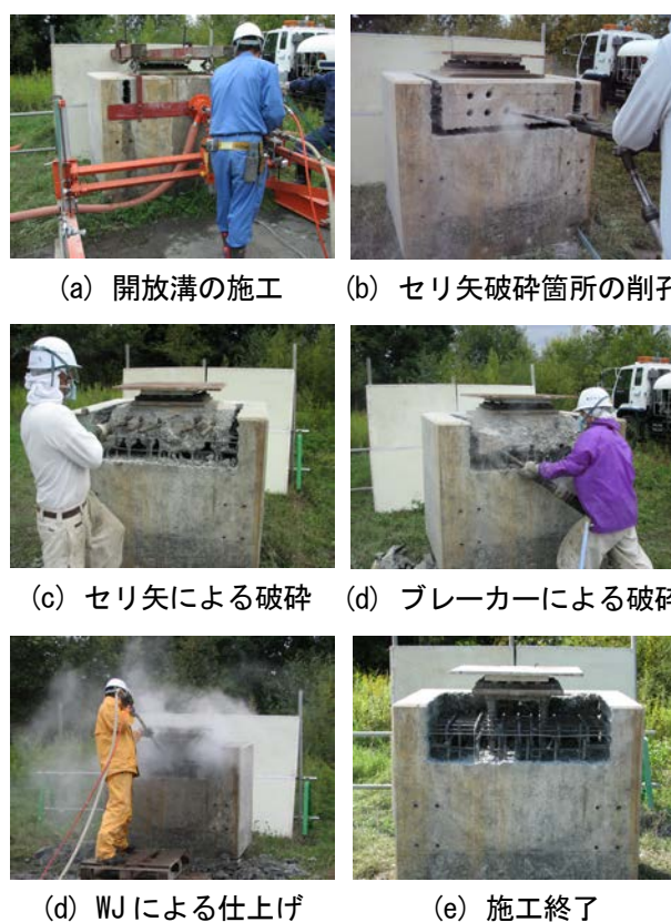
写真-6 施工状況
