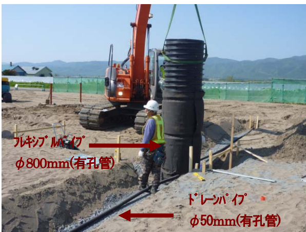
図10 センタードレーンの設置状況
