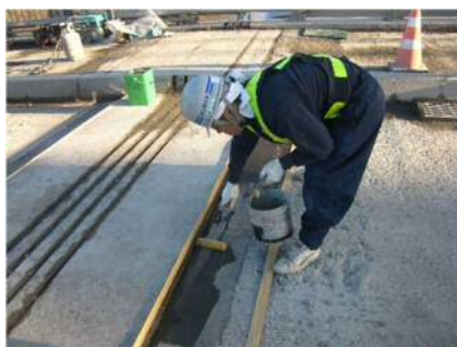
プライマー塗布
