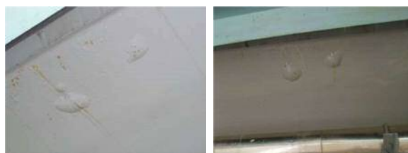
(2) 床版下面 ( \phi 10 \rightarrow \phi 20\text{cm} 程度)
