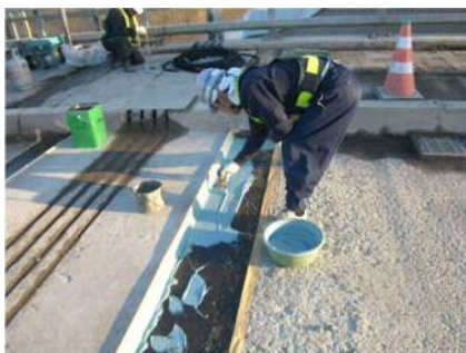
ウレタン施工
