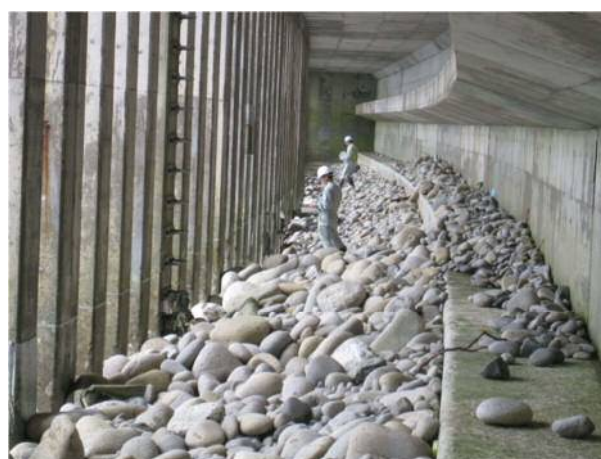
写真-3.12 内側での目視調査の様子（梯子が設置されている脚柱の番号は132）
