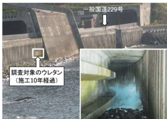
(右下は消波擁壁の内側で、波の吸収によって越波の抑制が図られている様子がわかる)
