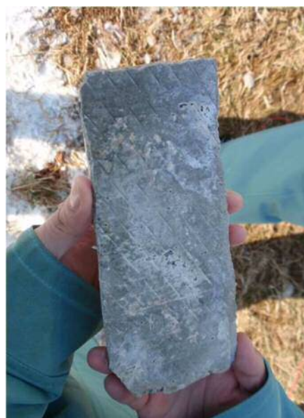
写真-4.8 保護材のシートとの接着面の状況
