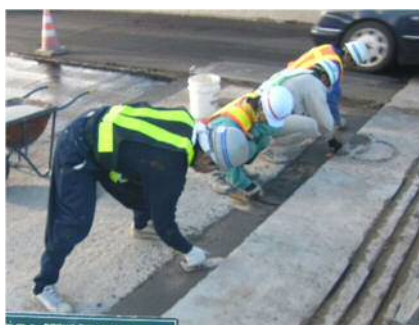
脆弱部の打換え
