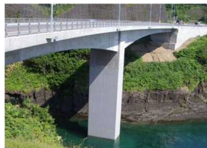
写真-2.1 埋設型枠工法の適用事例（橋脚）
