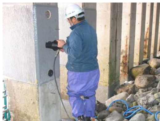
写真-3.5 付着強度の測定状況 (脚柱番号 No. 2、内-2)
