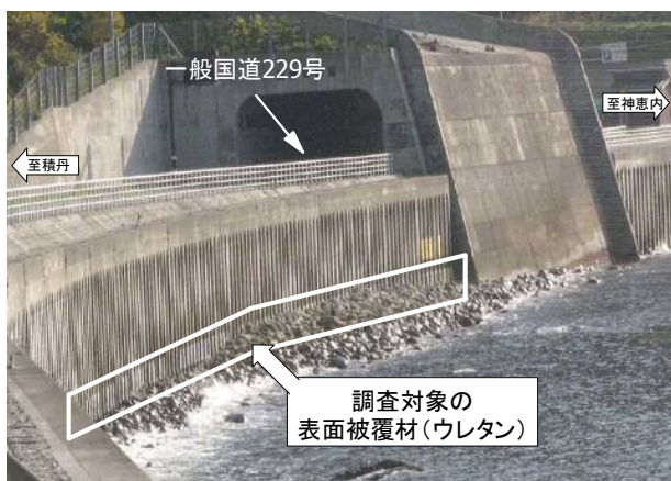
写真-3.10 調査対象のウレタン（施工約 20 年経過）の位置（白線で囲っている部分）
