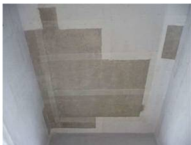
写真-4.16 スケルトンタイプのシート工法
