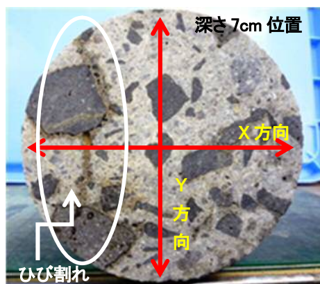
写真-2.7 目地部コアのひび割れ (埋設型枠版A目地部コア断面)
