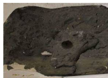
写真-4.13 コンクリートの層状剥離
