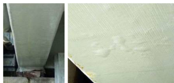
(3) 主桁下面 (なし \rightarrow 30 \times 60\text{cm} 程度)
