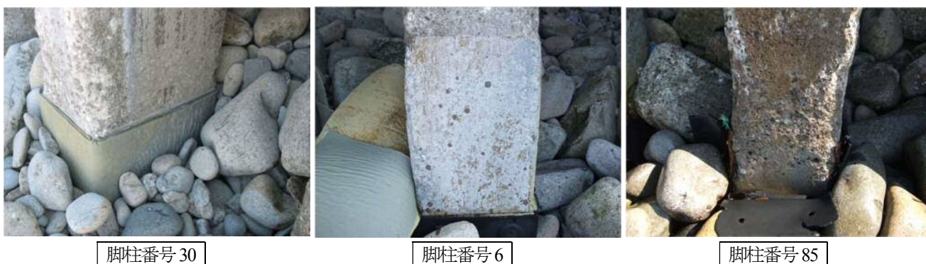
写真-3.13 海側から撮影した現場の状況の一例（脚柱番号 30 は、向かって左側の面が海側）
