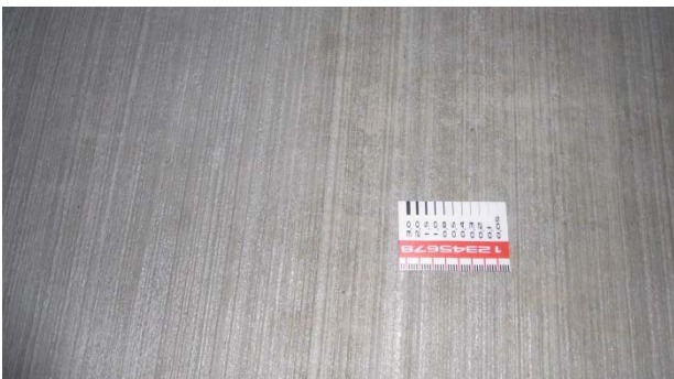
写真-1 施工直後のコンクリート舗装のほうき目仕上げ
