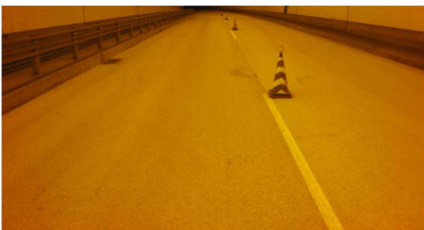
写真-6 トンネル内明色舗装（施工後）
