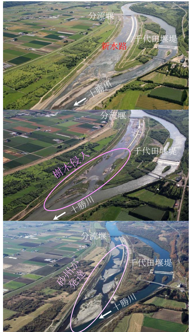
図 - 19 千代田新水路の変遷（上段：2007年7月帯広開発建設部撮影、中段：2010年7月撮影、下段：2011年10月撮影）
