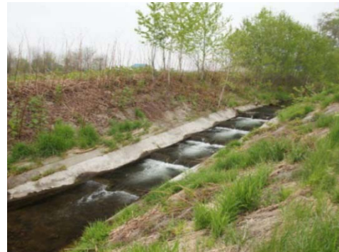
写真-1 A排水路における階段型落差工の外観
