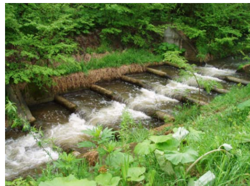
写真-2 B排水路における階段型落差工の外観
