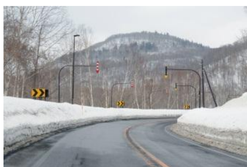
写真-9 茶系塗装により電柱が目立っている事例
