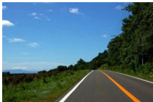
写真-7 実写真の比較による片寄せの景観向上イメージ
