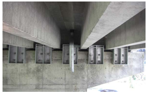
写真-3 落橋防止柵
