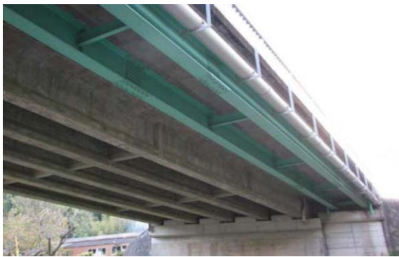
写真-1 橋梁端部・床板裏
