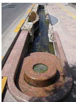
写真-2 せせらぎ水路B
