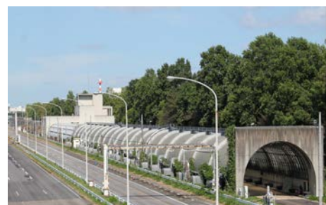
写真-1 実大トンネル実験施設
