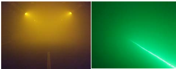
写真-4 トンネル内状況 写真-5 足下灯の状況
