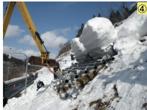
④ 重機による柵の傾倒
