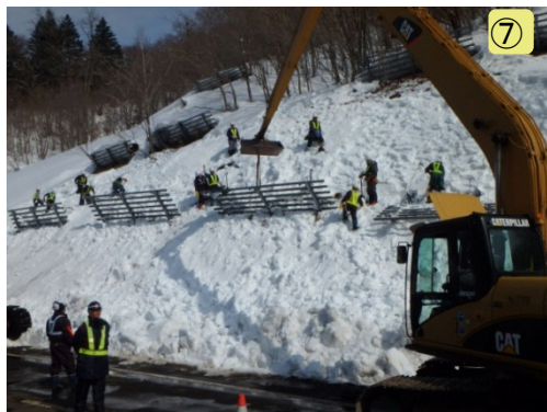
⑦ 重機による柵の吊り起こし
