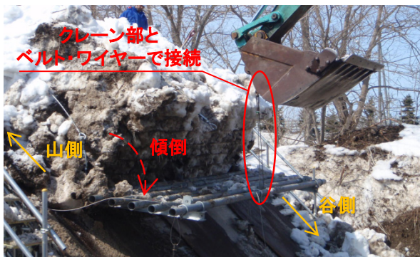
写真-7 傾倒・起立動作、作業性の確認状況
