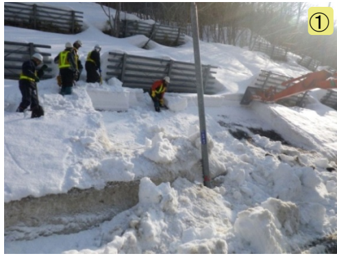
① 柵下の除排雪（機械施工）
