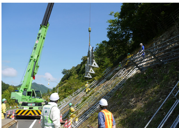
写真-12 傾倒式柵の設置作業状況
