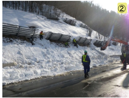
② 柵下の除排雪（人力施工）
