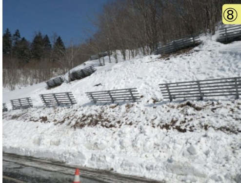
⑧ 除排雪完了後の法面
