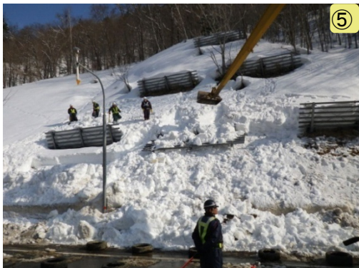
⑤ 柵背圧領域（山側）の除排雪（機械施工）
