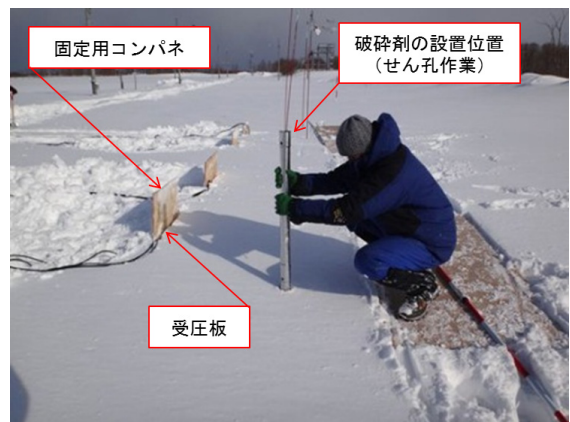
写真-15 せん孔作業状況
