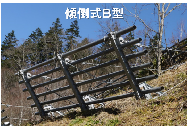
写真-10 雪崩予防柵の設置状況
