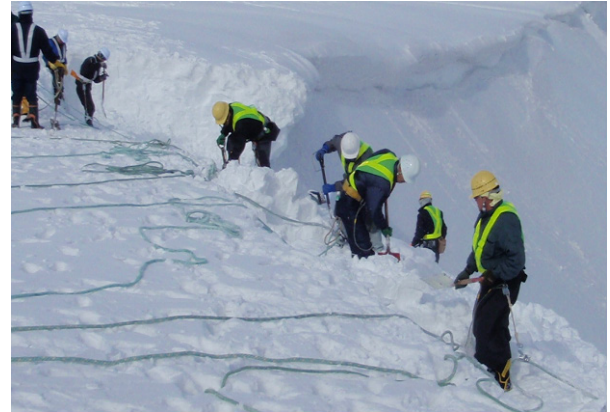
写真-20 人力施工による雪庇の除排雪状況
