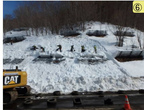
⑥ 柵背圧領域（山側）の除排雪（人力施工）
