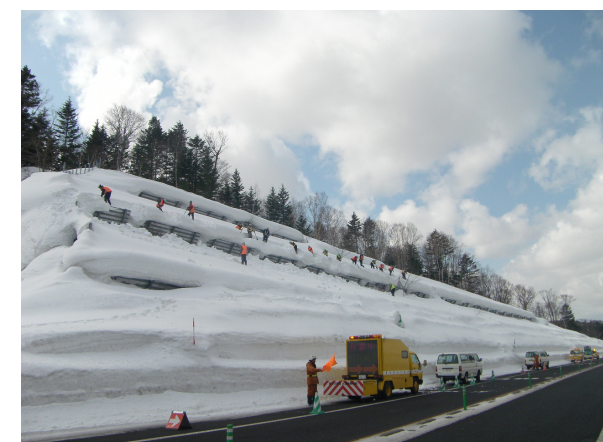
写真-1 雪崩予防柵周辺の人力による除排雪状況
