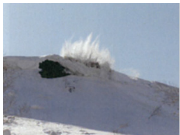
写真-18 非火薬破砕剤による雪庇の発破状況(イメージ)
