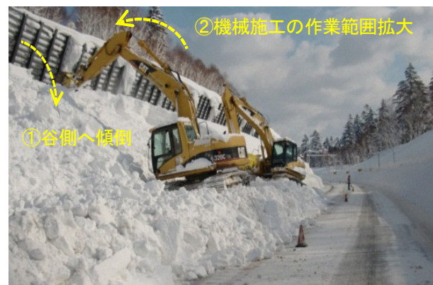
写真-8 機械施工の作業範囲の拡大イメージ
