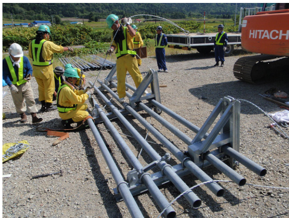
写真-11 傾倒式柵への改造作業状況
