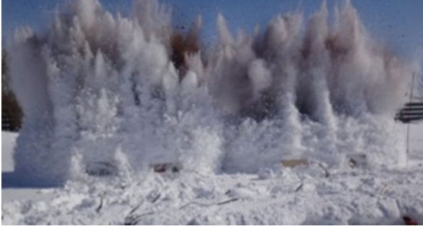
写真-16 発破状況（破砕剤 A、斉発発破）
