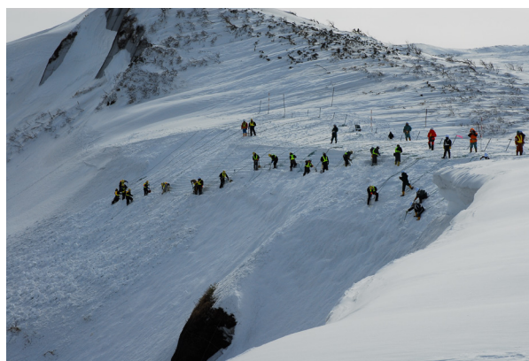
写真-2 大規模な雪庇の人力による除排雪状況
