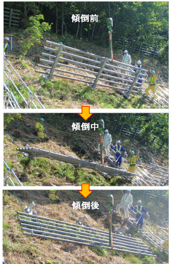
写真-13 傾倒式柵の傾倒動作確認状況
