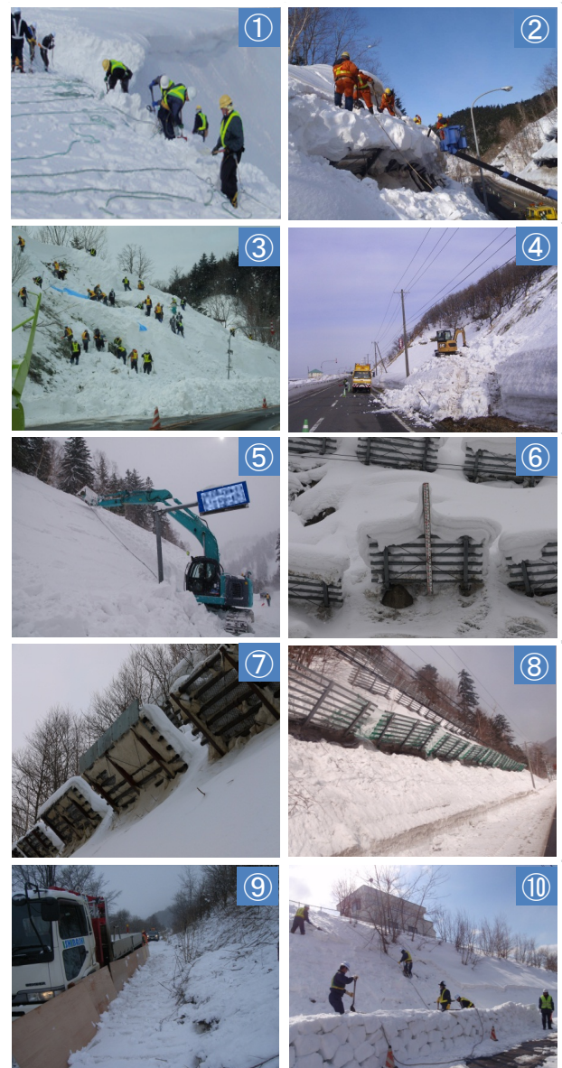
写真-3 道路法面事例集掲載の写真（抜粋）
