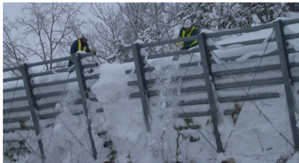
写真-5 雪崩予防柵の背圧領域（山側）の除排雪状況
