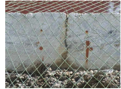
写真-6 目地部側面の状況
