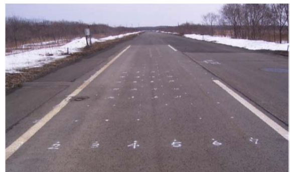
写真-14 凍上量測定箇所（苫小牧寒地試験道路）
