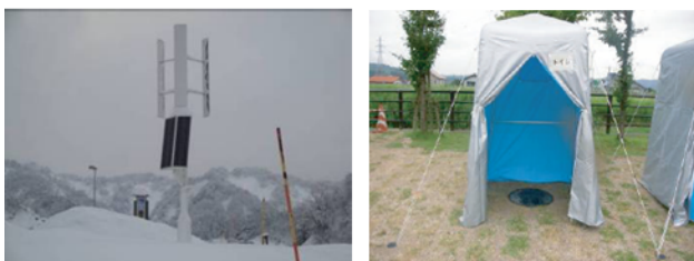
写真-10 左：平時はも有効な太陽光と風力発電の照明 右：マンホールを使用する非常用トイレ
