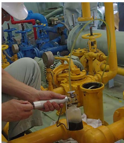
写真-27 フィルタハウジングを開放してのサンプリング
