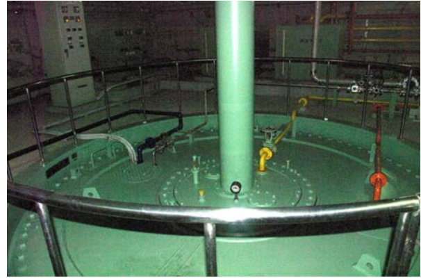
写真-13 コンクリートケーシングの場合
