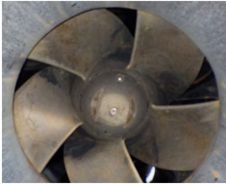
写真-7 O排水機場 羽根車状況 (摩耗劣化なし)
