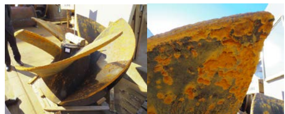
写真-4 S排水機場の羽根車の状況 (左：全景 右：端部拡大)
