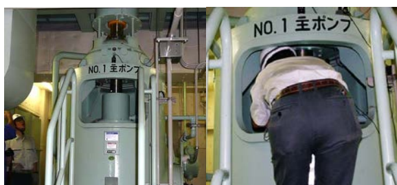
写真-9 軸封部直上の軸受をポンプケーシングで支持し開口部が小さい場合
