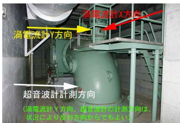
写真-3 主ポンプ振動の計測方向
