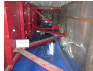
写真-8 養生状況
