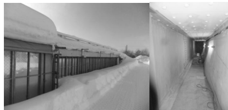
写真-5 養生状況
