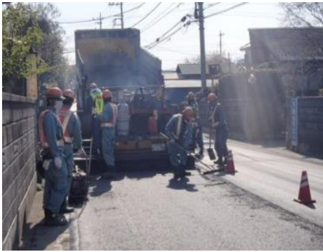
写真-14 敷きならし状況
