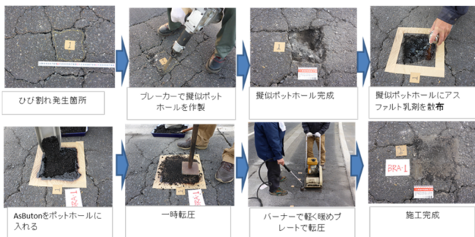
写真-10 耐久性試験の施工手順
