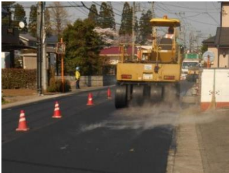
写真-15 二次転圧
